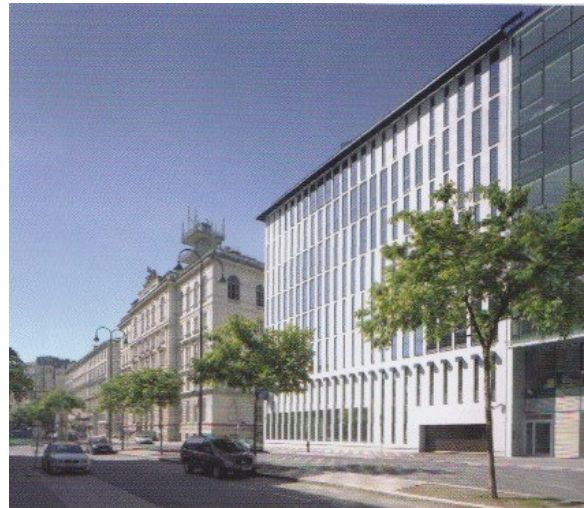
Abb.7: Das OPEC - Gebäude in der Wipplingerstraße fügt sich mit seiner zeitgemäßen Gestaltung durch Übernahme der Gebäudehöhe des Materials der Oberfläche und bedeutender Schattenlinien in die Straßenwand ein (aus: „Wien - Innere Stadt Weltkulturerbe und lebendiges Zentrum“ S. 25).
